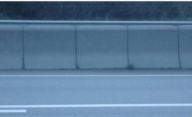
Til venstre er eksempel på betongrekjkverk og til høyre er det eksempel på betongrekjkverk New Jersey.
