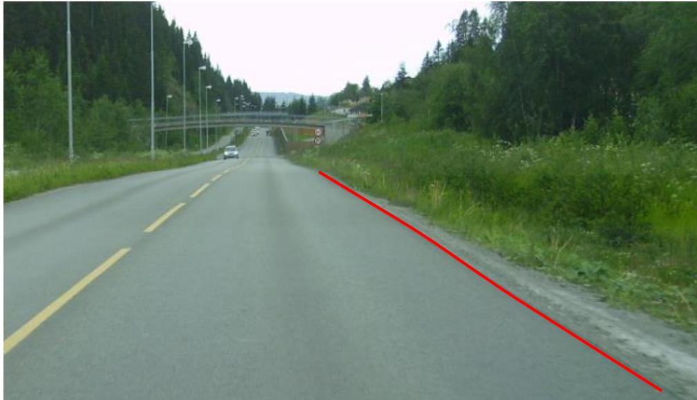
Figur 4: Eksempel på registrering av Vegdekkekant (asfaltkanten registreres – rød linje).
