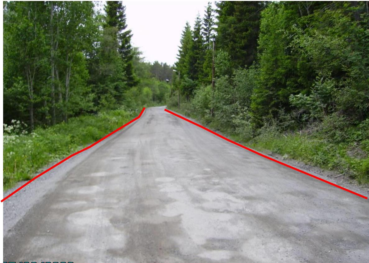
Figur 6: Eksempel på registrering av Vegdekkekant for grusveg.
